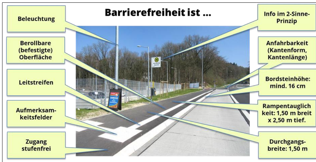
Abb. 9: Barrierefreie Gestaltung einer Haltestelle (Mindeststandards)
